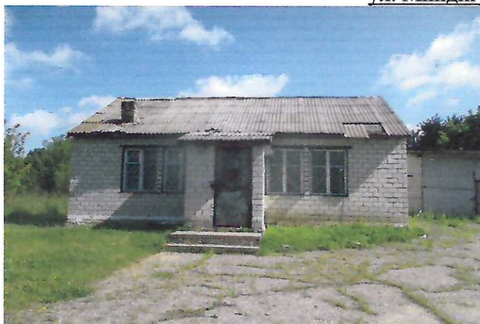
21.07.2023г., А1/кз — Здание магазина №77, 1 — тамбур, 2 — пристройка холодная
