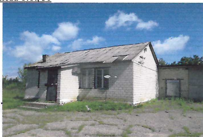
21.07.2023г., А1/кз — Здание магазина №77, 1 — тамбур, 2 — пристройка холодная
