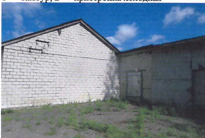
21.07.2023г., А1/кз — Здание магазина №77, 2, 3 — пристройка холодная
